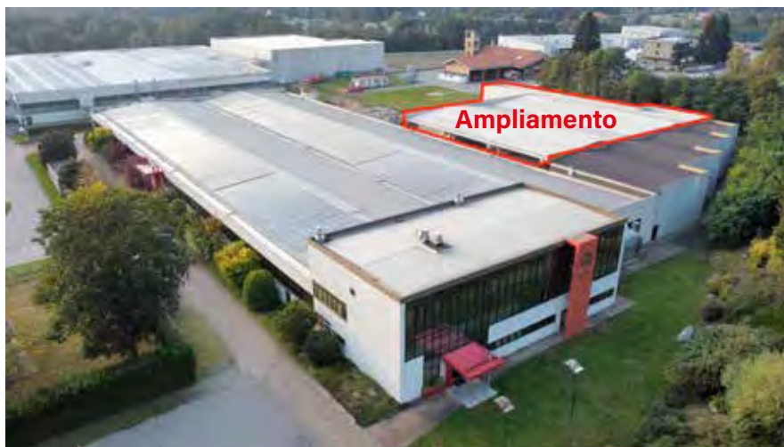
Vista aerea con il nuovo ampliamento
